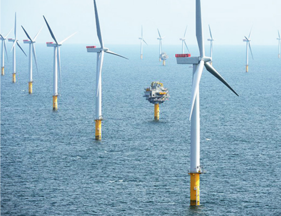
As turbinas de 260 metros de altura serão instaladas usando uma embarcação especializada com capacidade de içamento
